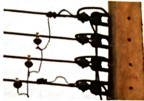
รูปที่ 5.9 การติดตั้งแร็กต้นสุดท้าย
