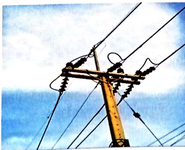
รูปที่ 5.2 การติดตั้งคอนสายคู่
